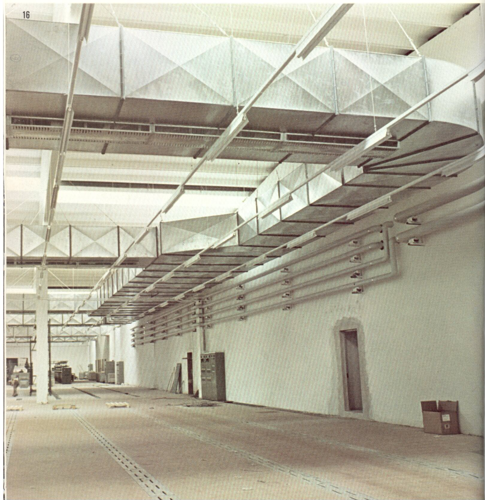
16) Industria tessile: filatura di cotone. Particolare collettore di distribuzione dell'aria derivato da centrale adiabatica per il trattamento di 320.000 mc/h di aria.
