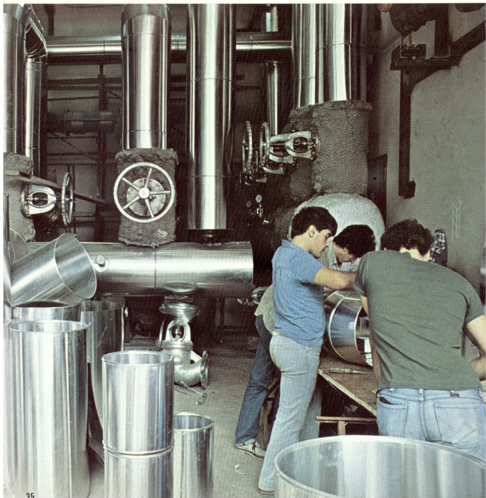
35) Fase di montaggio di isolamento termico mediante TELISOL 65 spessore 100 mm con guscio esterno in lamiera di alluminio.
